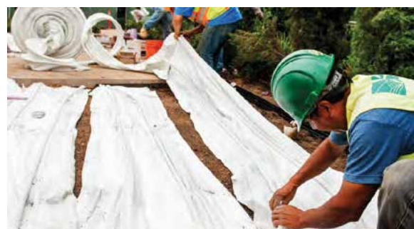
Пример установки Eco-Mat
